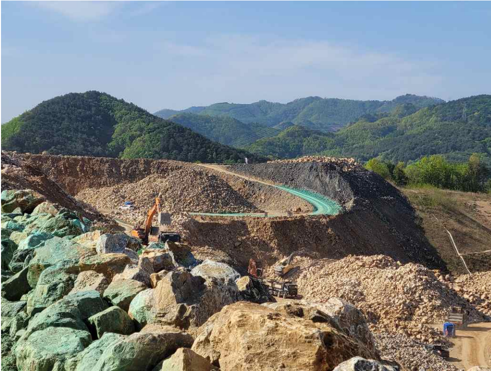
도로에 비산먼지저감제 살수
