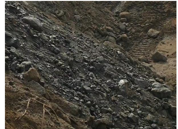
비산먼지저감제 살포 후 상태
