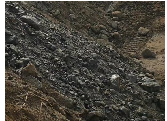
비산먼지저감제 살포 후 상태
