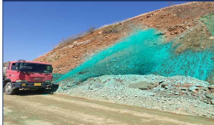
강원 삼척화력발전소 현장: 포스코
