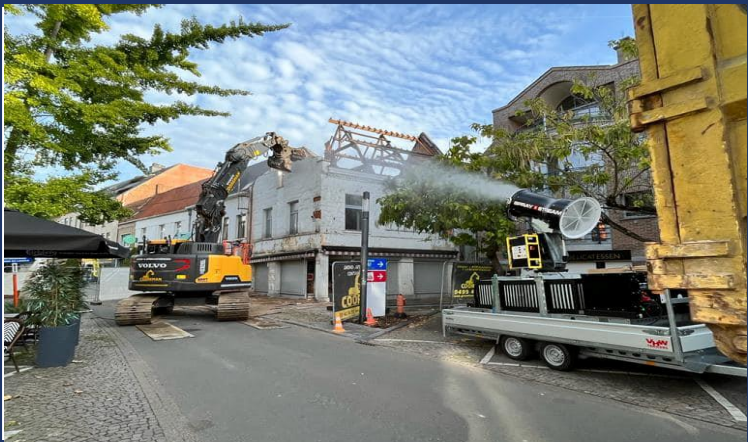
시내 주택 건설현장
