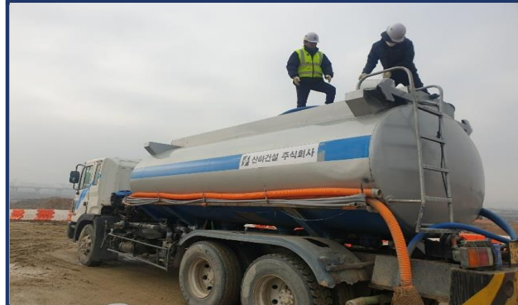
아산 탕정지구 현장: 포스코
